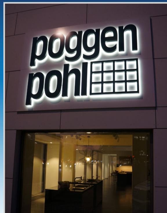
Großbuchstaben im Profil plan, gefräst aus 3 mm Aluminium / Kunststoffverbundmaterial, teilweise mit Folie belegt. Unsichtbare Befestigung mit Kunststoffhaltern.
