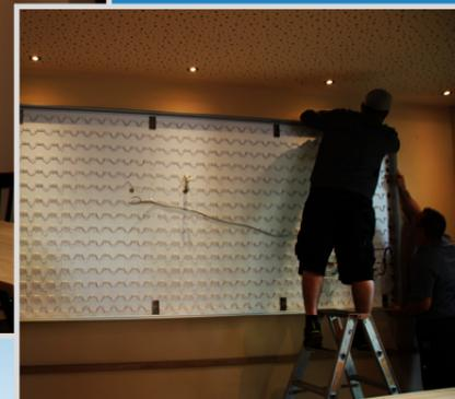
LED-Technik im Spanntuchrahmen aus Aluminium, Bautiefe 80 mm
