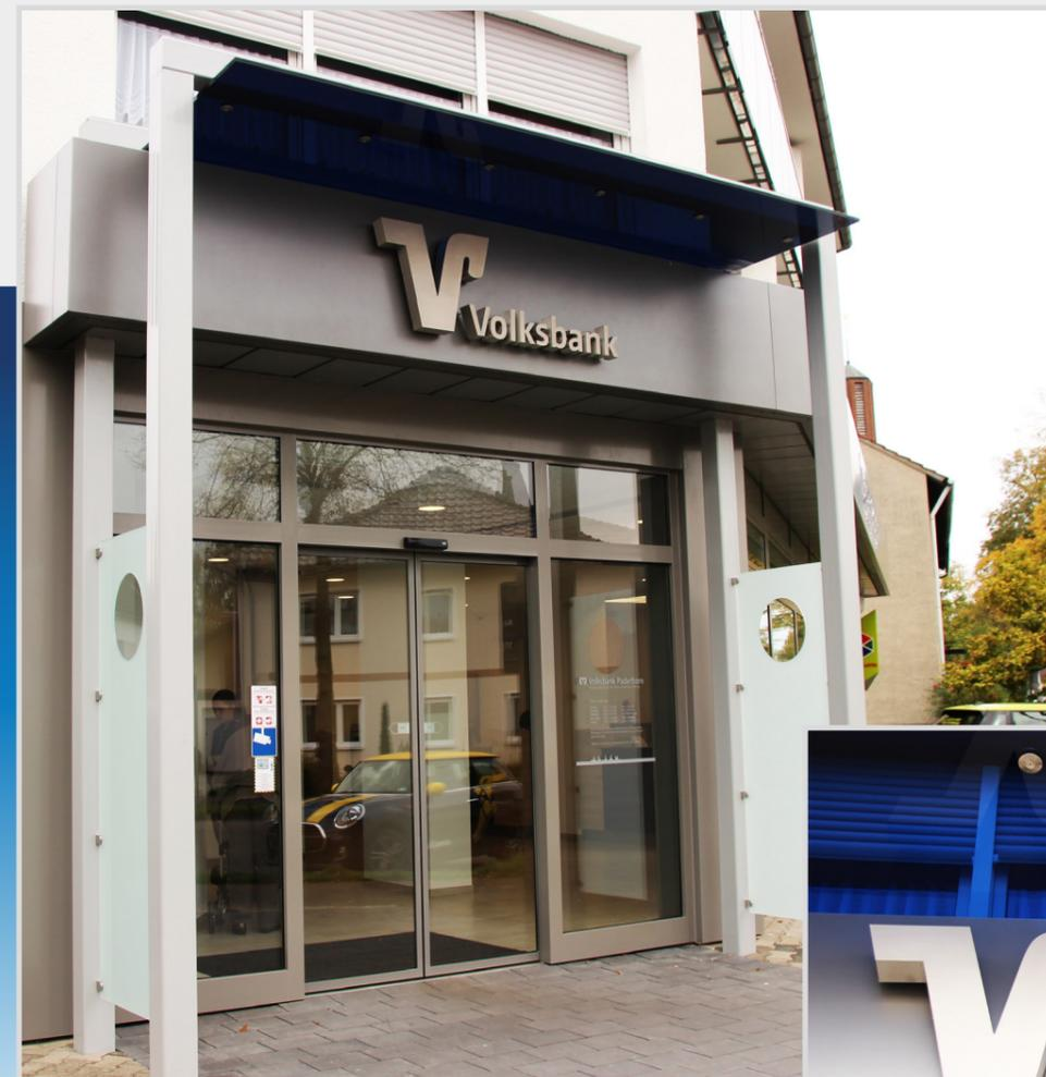
Kombination aus Stahl/ Aluminium/ Glas/ V2A und LED-Technik
